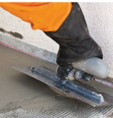
Applicazione di Monogum con spatola metallica liscia
