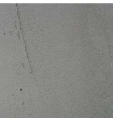
Intonacatura con intonaco deumidificante Idrostop
