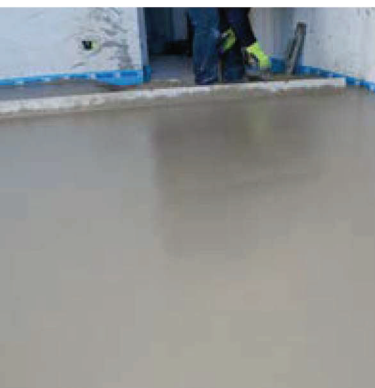
Esempio di sottofondo alleggerito per massetto Thermoisol
