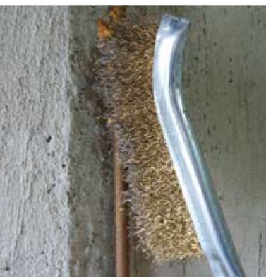
Pulizia mediante spazzola metallica del ferro da trattare
