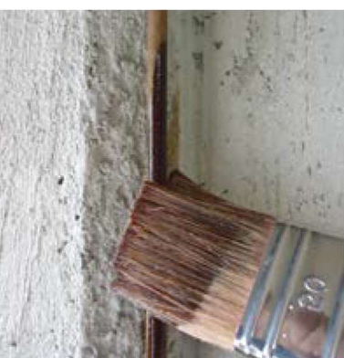
Trattamento con convertitore di ruggine Top Fer e/o passivante
