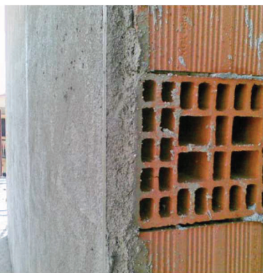
Esempio di applicazione dell'intonaco isolante Thermoisol
