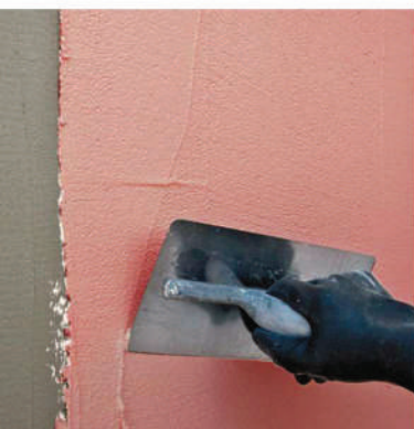
Applicazione di Tonacolor Silox con spatola metallica
