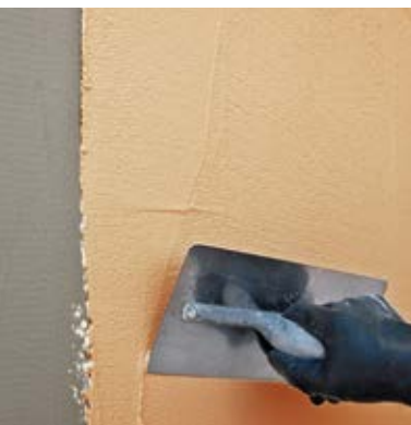
Applicazione della prima passata di Intodecor con spatola di acciaio
