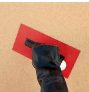
Lavorazione finale con fratazzo di plastica
